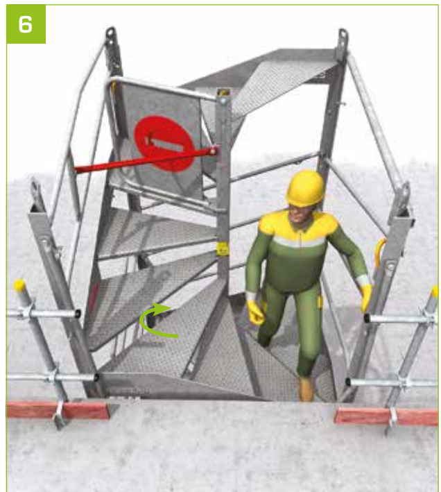
- S'assurer que les amarrages sont installés avant le décrochage des élingues. - Basculement des garde-corps pour permettre la sortie au niveau souhaité.
